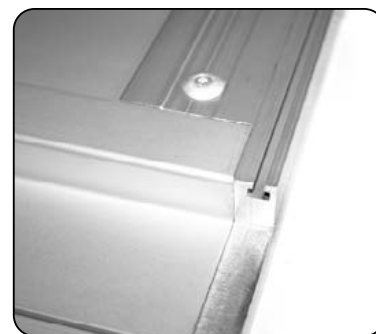
T drážka ( vedení těsnění ) T drážka ( vedenie tesnenia ) Rowek T ( prowadzenie uszczelki )
