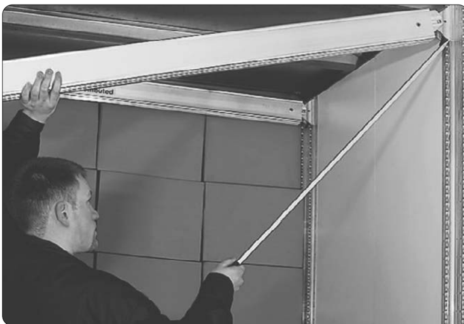
Nasadenie nosníka ATD/ Montaż nośników ATD
